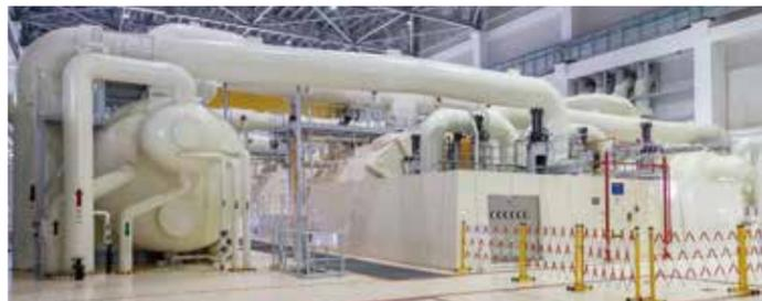
热电系统的核心，利用高温高压蒸汽做功发电的设备。
