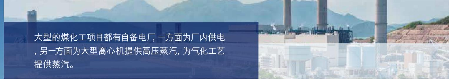
大型的煤化工项目都有自备电厂，一方面为厂内供电，另一方面为大型离心机提供高压蒸汽，为气化工艺提供蒸汽。
