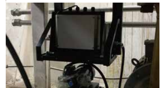
设备：中铁工程装备11.7m盾构推进液压系统 工厂：某建设集团股份有限公司吴兴至临安公路南河隧道段工程项目
